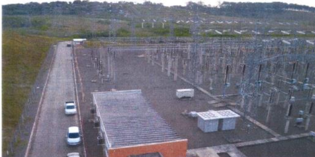
Fig. 3 e 4 – Vista da Área destinada a ampliação da SE Scharlau 2 – 1 EL 230 kV
